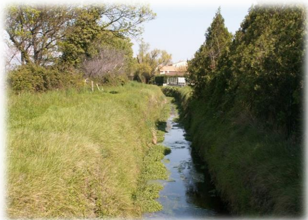
Photo 7 : Fossé « Roubine de Raillon » -Source : SMC LG. (2010)
