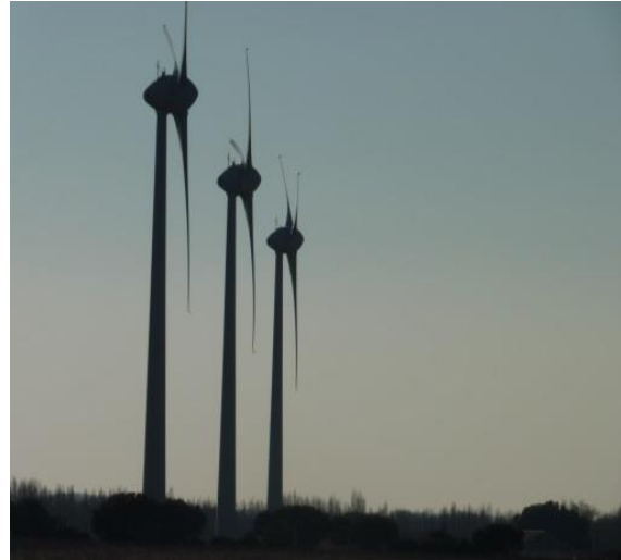
Photo 26 : Parc éolien du Mas de Leuze - Source : SMC (2012)
